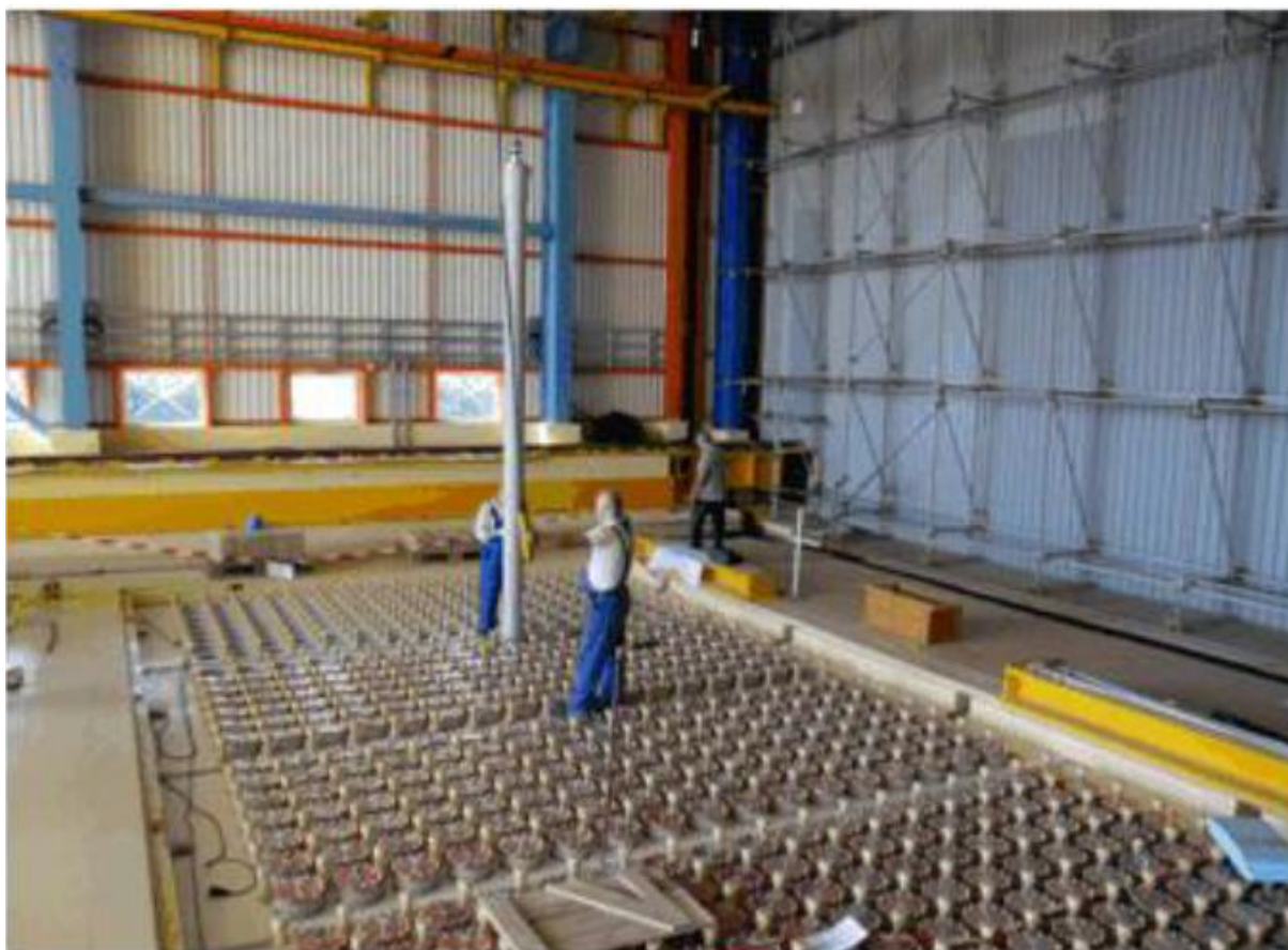
1.2-2. kép: Tároló csövek beemelése
