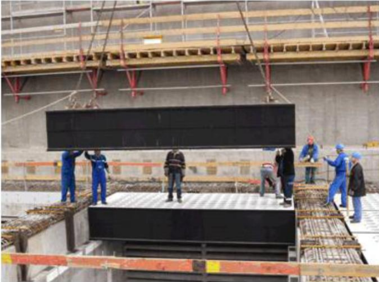
1.2-1. kép: A III. ütem 1. fázis építésének munkái: a betárolófedélzet elemeinek beemelése
